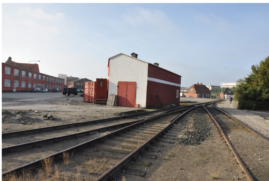
Figur 8-M Foto af bygning B41, der ryddes som en del af projektet.
