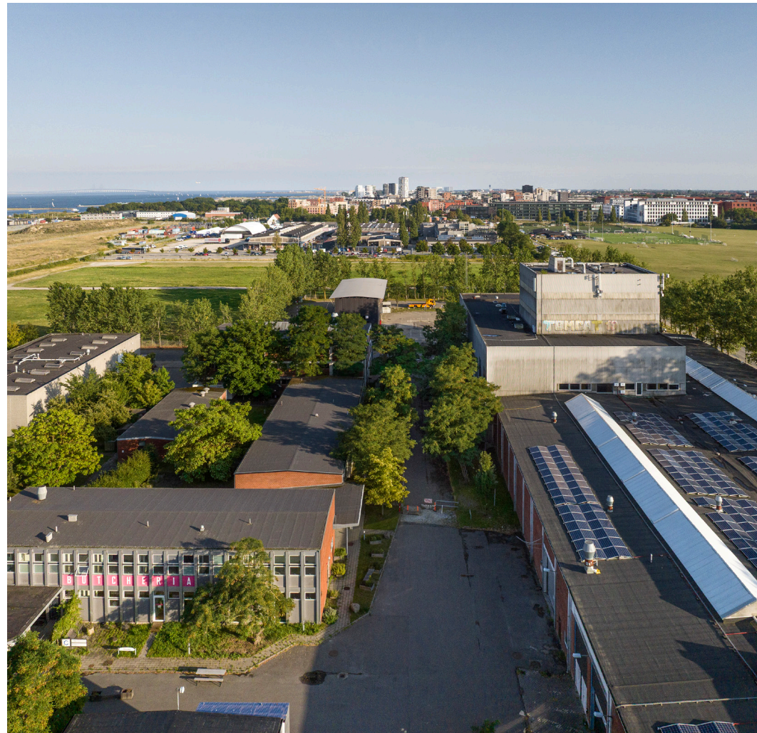
DEN NORDLIGE BYGNINGSENKLAVE SET FRA LUFTEN
