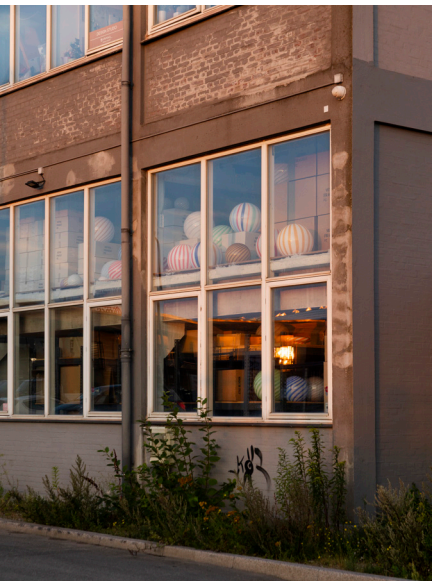
EKSISTERENDE BEBYGGELSE VED PRAGS BOULEVARD/PRØVESTENSBRØEN
