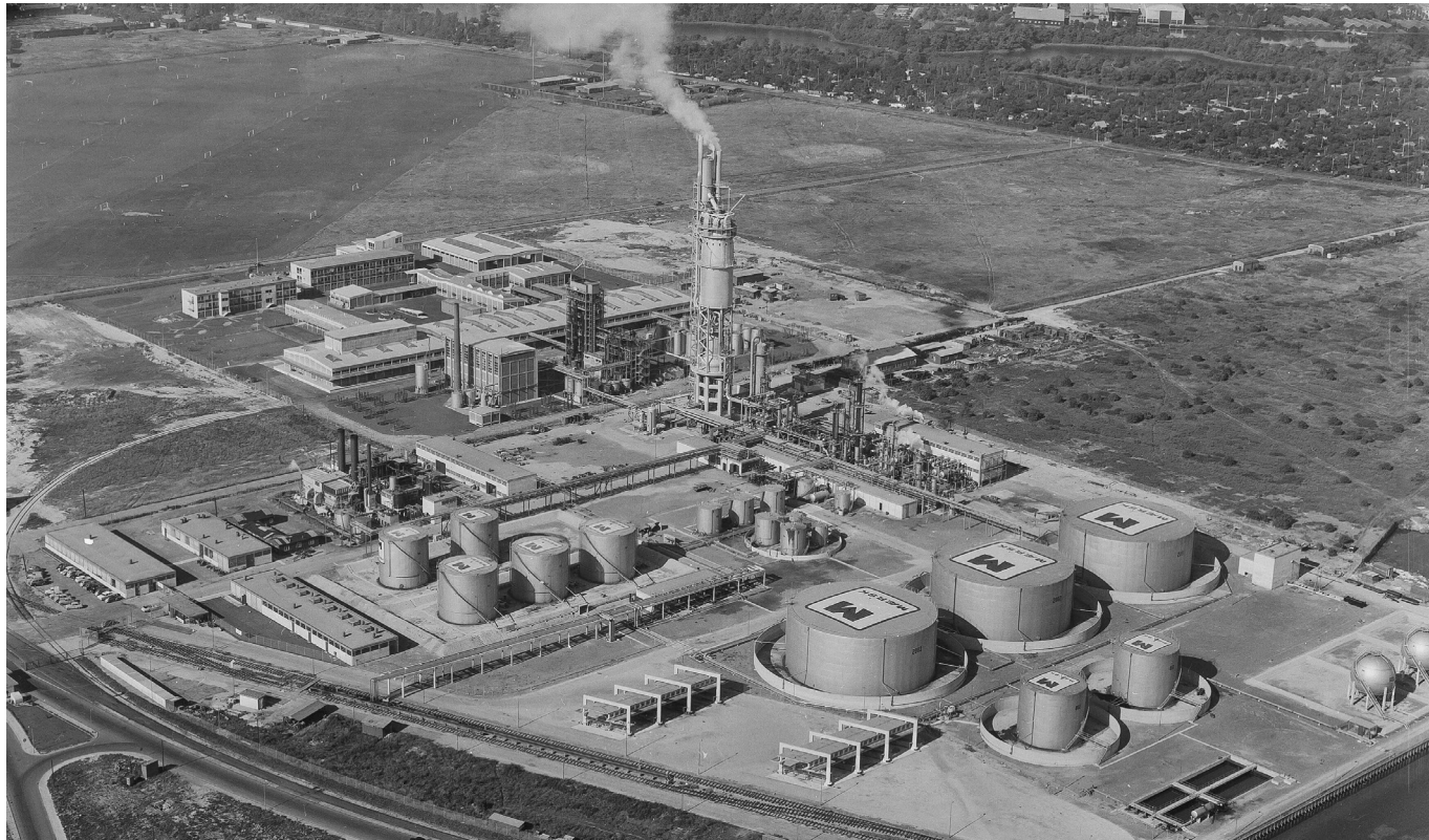
PYROLYSEVÆRKET SET FRA LUFTEN, 1965
