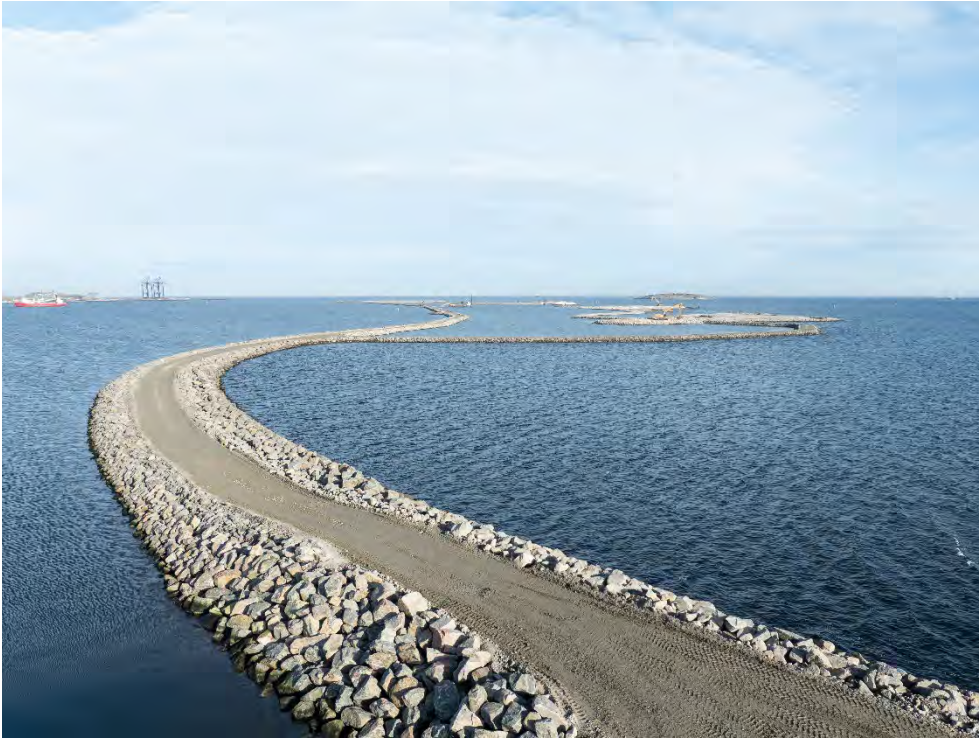
Østlig perimeter i september 2025
