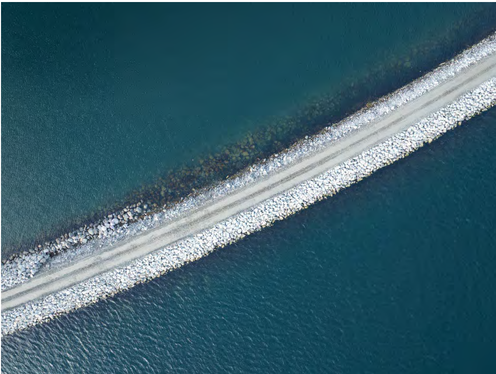
Opbygning af vestlig perimeter i november 2025
