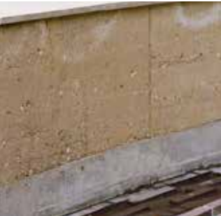
Jord Stampet lerjord kan bruges som bærende element i lette konstruktioner, det er potentielt lokalt tilgængeligt i Nordør og det vil også kunne genanvendes i et cirkulært perspektiv.
