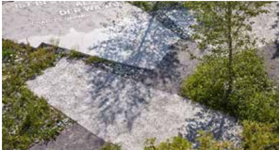
Genbrugsbeton Der findes flere projekter hvor man bruger overskudende beton til at anlægge nye belægninger – i både store og små formater.
