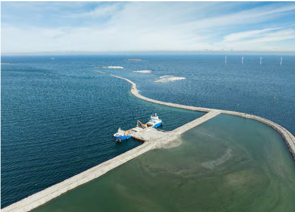
Fase 1 og den østlige perimeter på fase 2 og strongpoints i marts 2025
