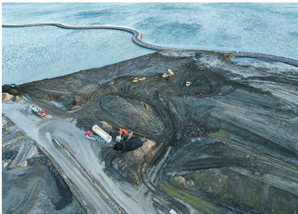
Fase 1 med opfyld og bassin til havbundssediment i december 2024
