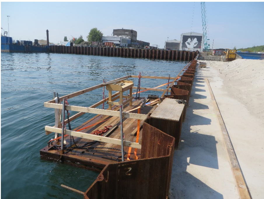
Ny kaj under opførelsen i vandet ud for Refshaleøen. Billedet er taget fra kajen med kig ind mod Refshaleøen. August 2022.
