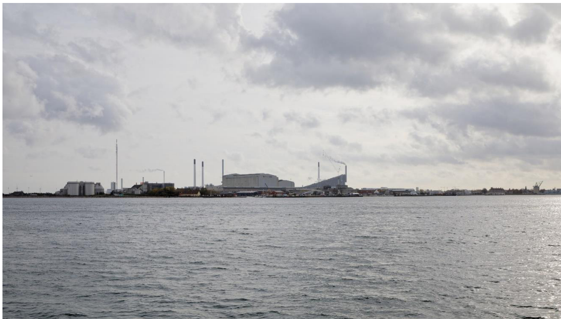
Fotostandpunkt – 3 sydøst – eksisterende forhold og 0-alternativ set fra Langelinie. 0-alternativet er tilsvarende de eksisterende forhold, da hverken Nordhavn eller Lynetteholm kan ses fra fotostandpunktet. 0-alternativet viser udsynet fra fotostandpunktet, hvis planen ikke gennemføres.
