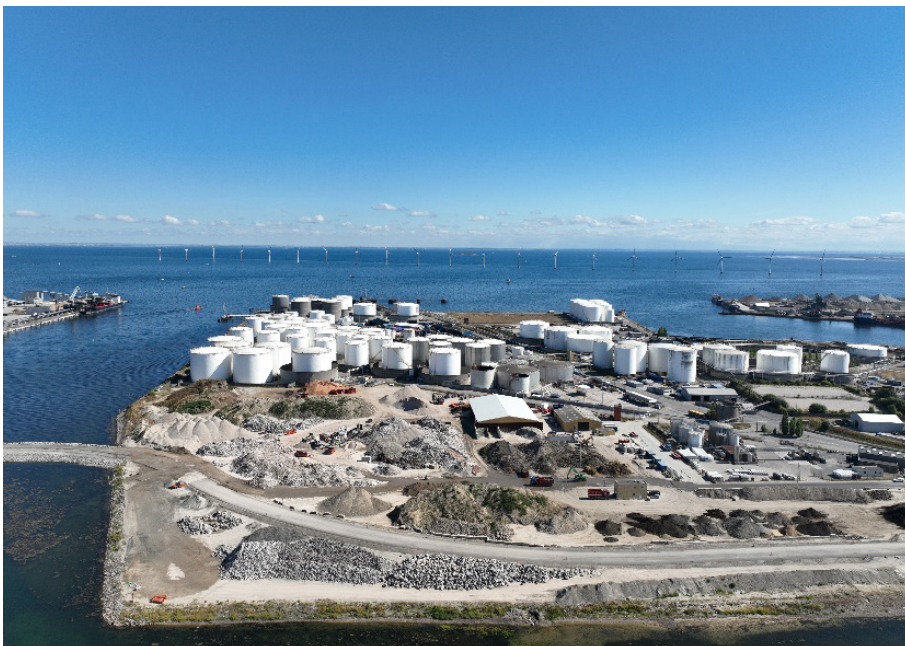
Etablering af jordtransportvej på Prøvestenen, som løber sammen med ny vejdæmning over Prøvestenskanalen. August 2022.
