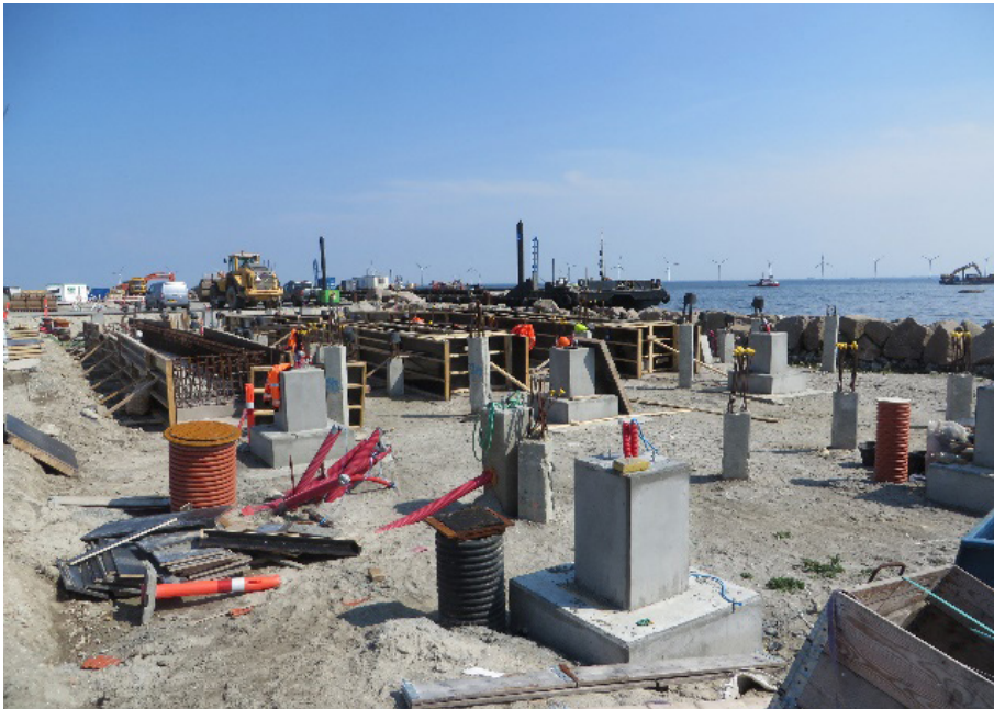
Jordmodtageanlæggets byggeplads. August 2022.
