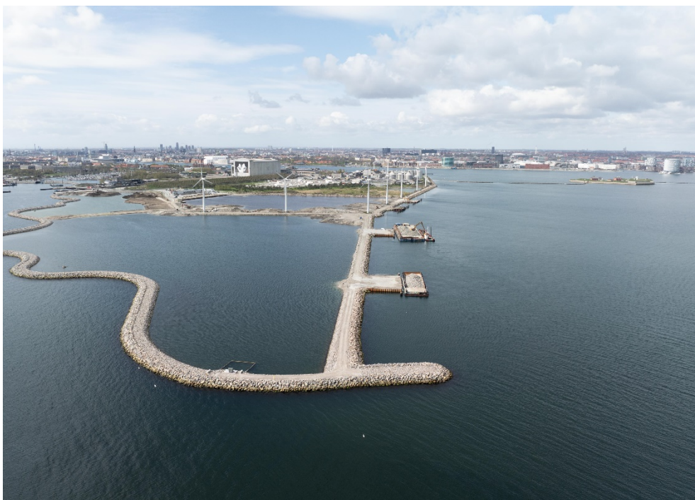
Fase 1 perimeteren i april 2024. Intern dæmning og brohoveder er etableret.
