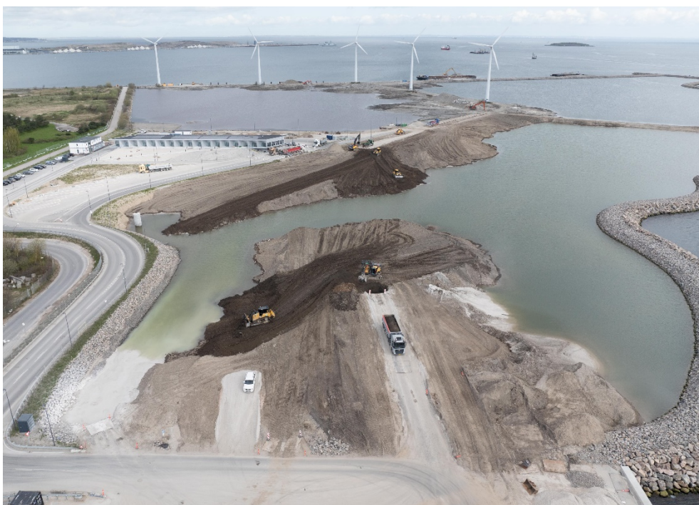
Administrationsbygningen, Lynette depotet og Fase 1 i april 2024
