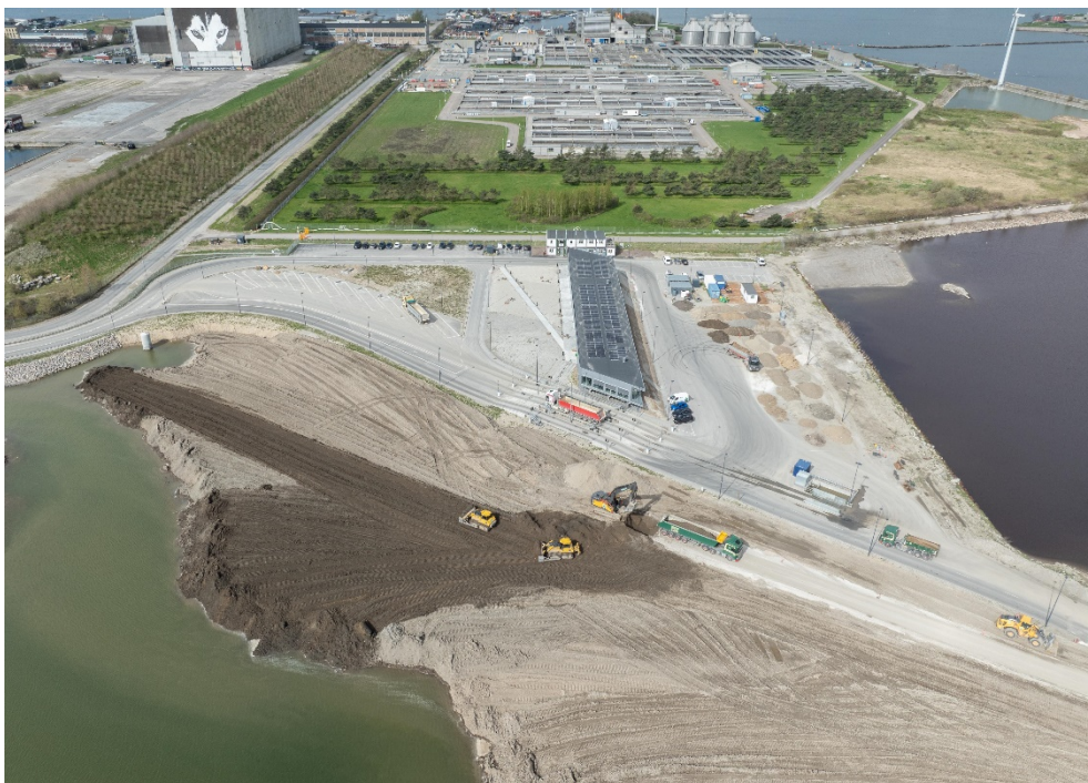
Vejerboden og opfyld i Fase 1 i april 2024.
