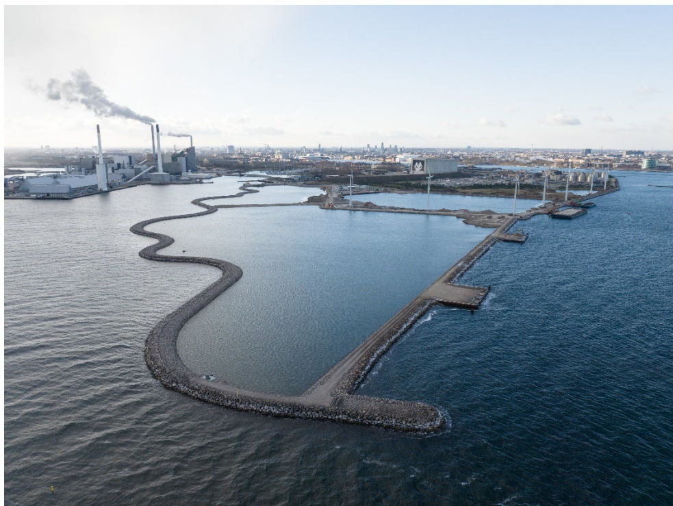
Fase 1 perimeteren i oktober 2023. Intern dæmning og brohoveder er etableret.
