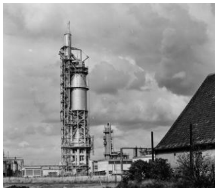
PYROLYSEVÆRKET MED KRUDTHUSET I FORGRUNDEN, 1965
