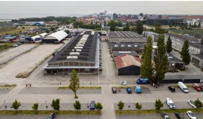
DEN SYDLIGE BYGNINGSENKLAVE SET MOD AMAGER STRAND
