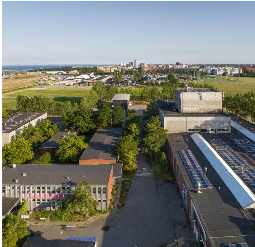
DEN NORDLIGE BYGNINGSENKLAVE SET FRA LUFTEN
