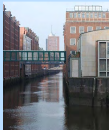
HAMBORG HAVN, Bygningerne danner kystsikring
