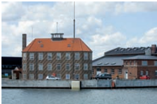
Lodsbbygningen "Lodseriet" er opført i 1942 som Lods- og Karantænestation.
