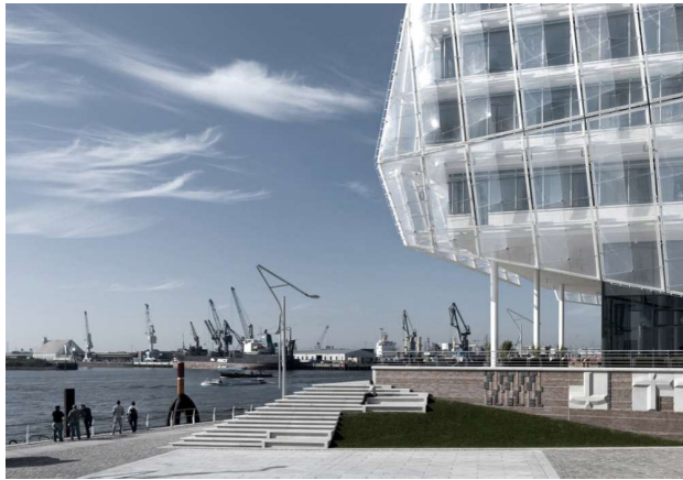
Redmolen skal indeholde besøgsmaal, en 'attraktor', der er åben for offentligheden. Unilever, Hamborg, Ark. Behnisch Architekten
