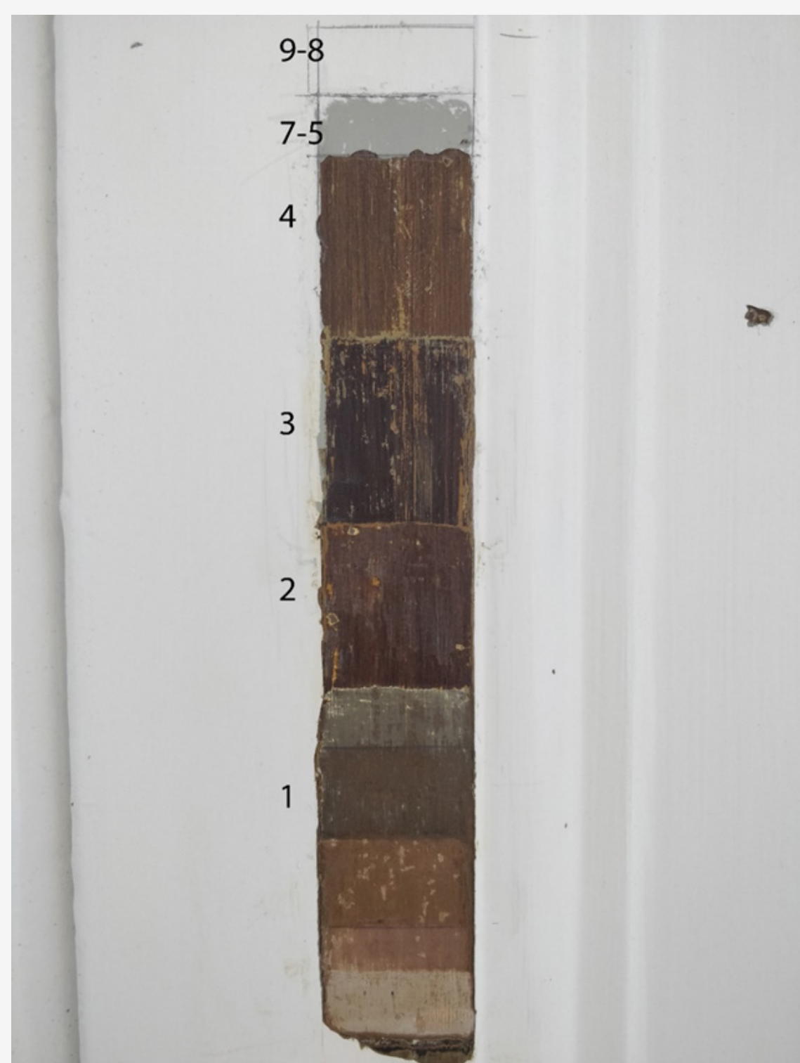
Dørindfatning entré. Den oprindelige mahogni imitation lag 1 er bygget op af mange laserende rødbrune lag
