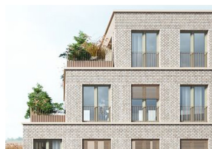
Nedtrapping udnyttes til terrasser og værnets farve er tilpasset facadens udtryk
