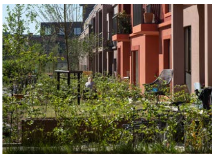
01: Sydvendt kantzone med private have med plads til mellemhøj beplantning og buske
