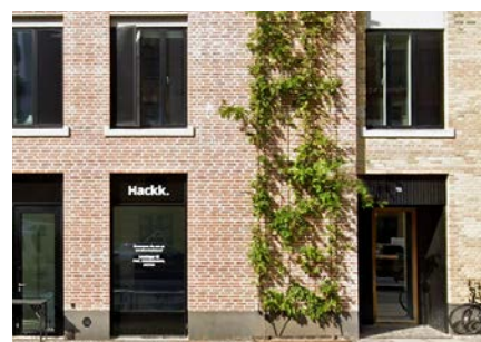
Facadebeplantning markerer indgangen
