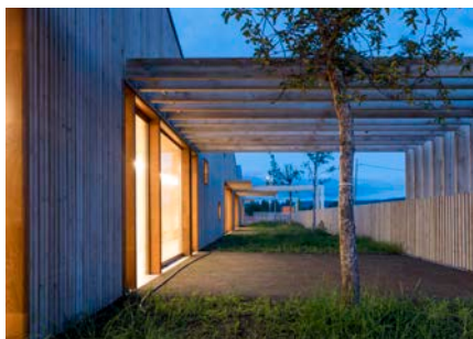
Overdækninger integreret i både facadeudtryk og hegn
