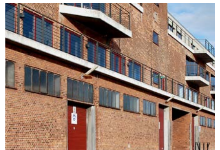
Røde tegl, metalvinduer og -døre
