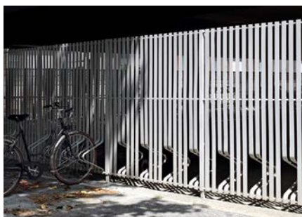
Hegn med integreret cykelparkering
